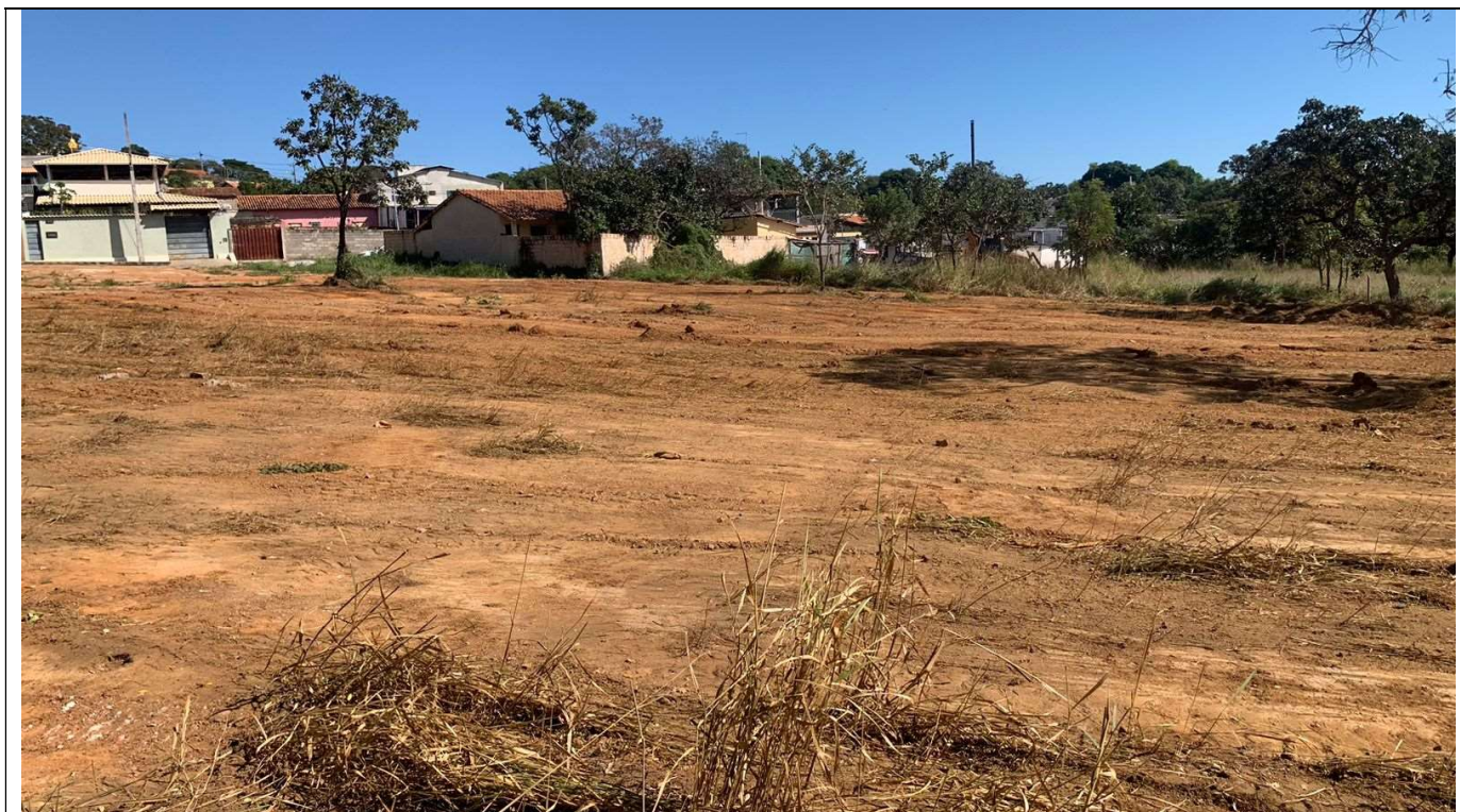
Foto 6: Terreno aonde será construída uma Quadra Poliesportiva para Escola Municipal São Bernardo na Sede do Município de Baldim-MG. Fonte: Próprio autor.
