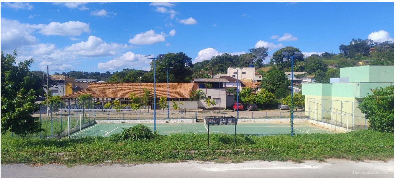
Foto 3: Foto do Terreno aonde será construída uma Quadra Poliesportiva para Escola Municipal Nelson Ribeiro da Silva, Distrito de São Vicente, Município de Baldim-MG. Fonte: Próprio autor.
