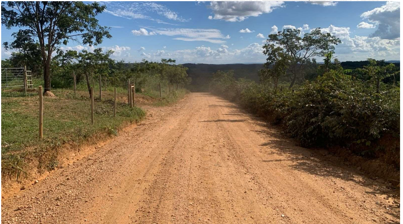
Foto 13: Morro da Cuia, localizado na Estrada Vicinal que interliga os Distritos de Vila Amanda e Vargem Grande à Comunidade da Cuia no Município de Baldim-MG. Fonte: Próprio Autor, 2026.
