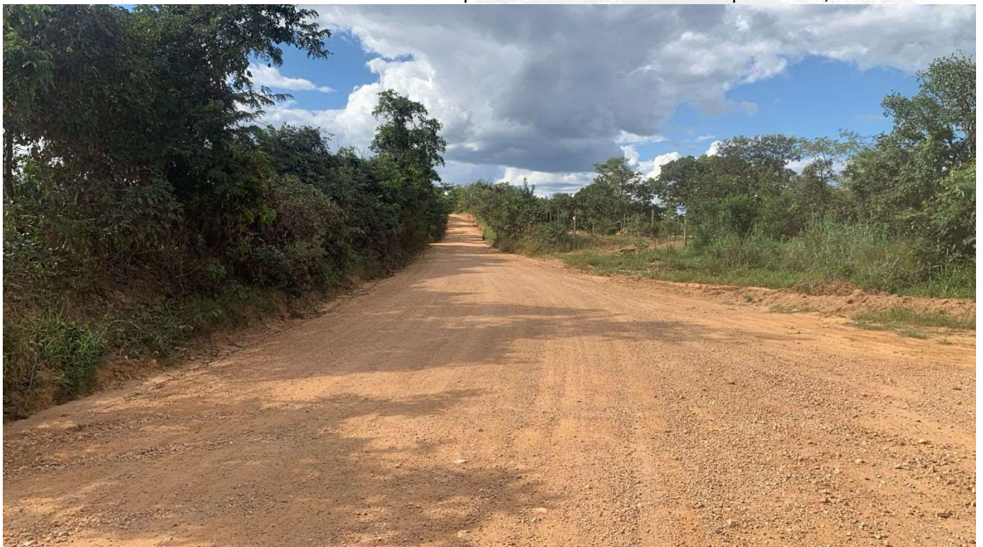
Foto 17: Morro da Cuia, localizado na Estrada Vicinal que interliga os Distritos de Vila Amanda e Vargem Grande à Comunidade da Cuia no Município de Baldim-MG. Fonte: Próprio Autor, 2026.
