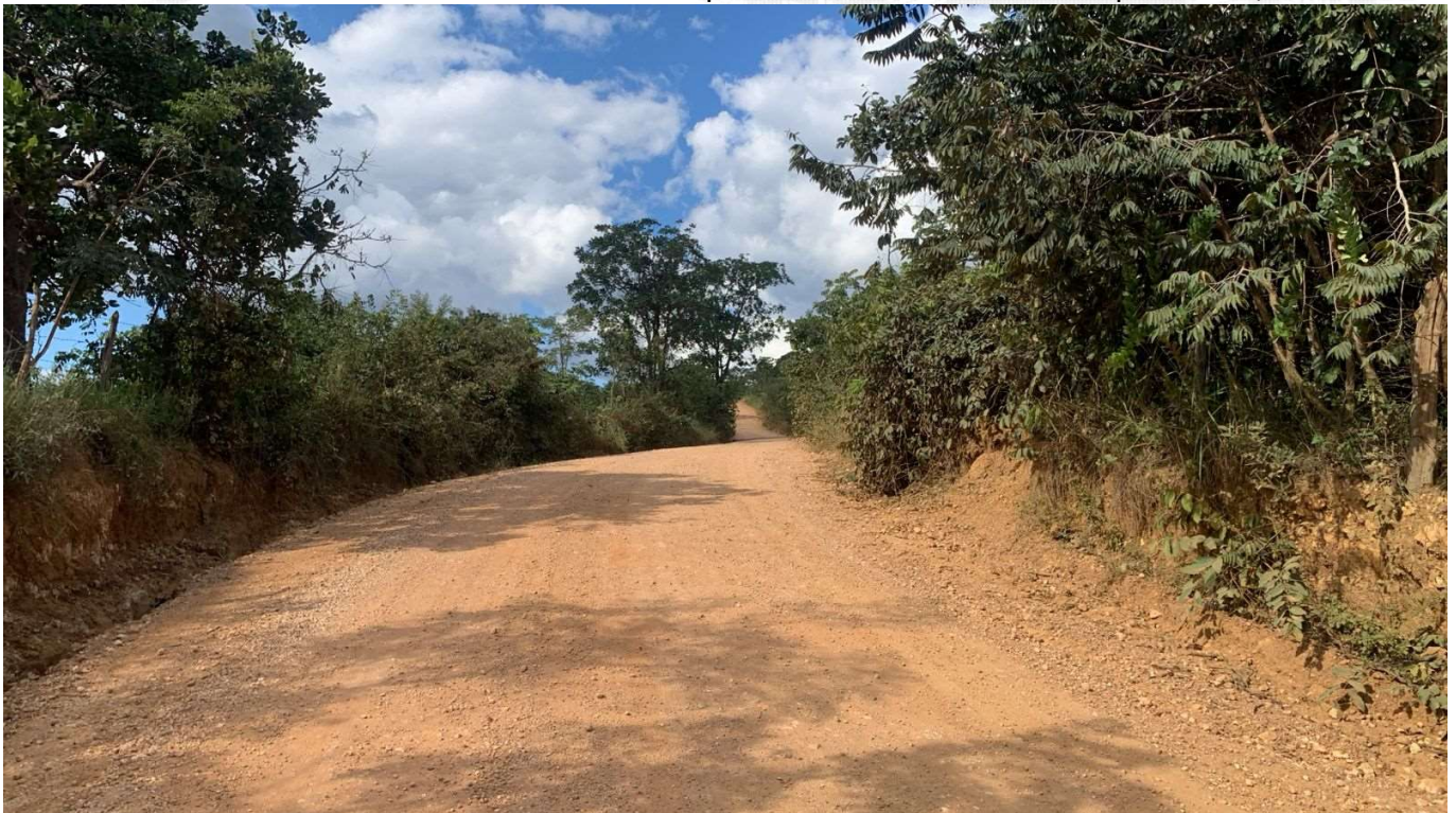
Foto 9: Morro da Cuia, localizado na Estrada Vicinal que interliga os Distritos de Vila Amanda e Vargem Grande à Comunidade da Cuia no Município de Baldim-MG. Fonte: Próprio Autor, 2026.
