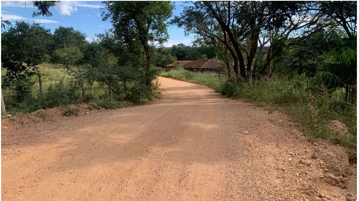
Foto 4: Morro da Cuia, localizado na Estrada Vicinal que interliga os Distritos de Vila Amanda e Vargem Grande à Comunidade da Cuia no Município de Baldim-MG. Fonte: Próprio Autor, 2026.
