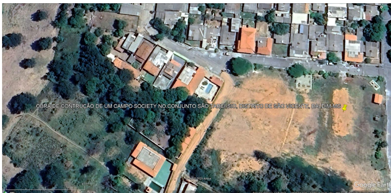
Foto 1 Conjunto São Tarcísio, Distrito de São Vicente, Município de Baldim-MG. Fonte: Google Earth. Coordenadas Geográficas do Ponto P1: X = 611560.5800”S. e Y = 7861891.9200”O.
