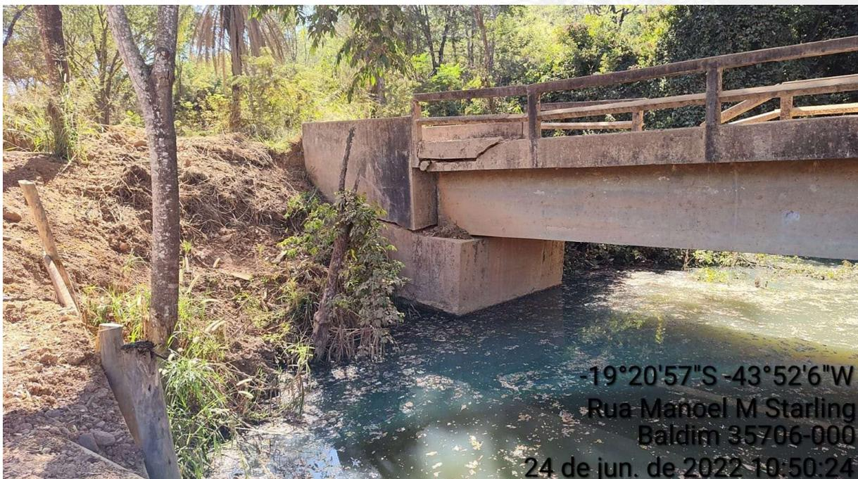
**Foto 5:** Na Vista Lateral Esquerda da Ponte em Concreto Armado (Lado do Povoado da Cuia) Bloco de Fundação Recalcado, Tabuleiro desnivelado e Rachaduras no Guarda-Rodas e Guarda-Corpos. Fonte: Próprio Autor, 2022.
