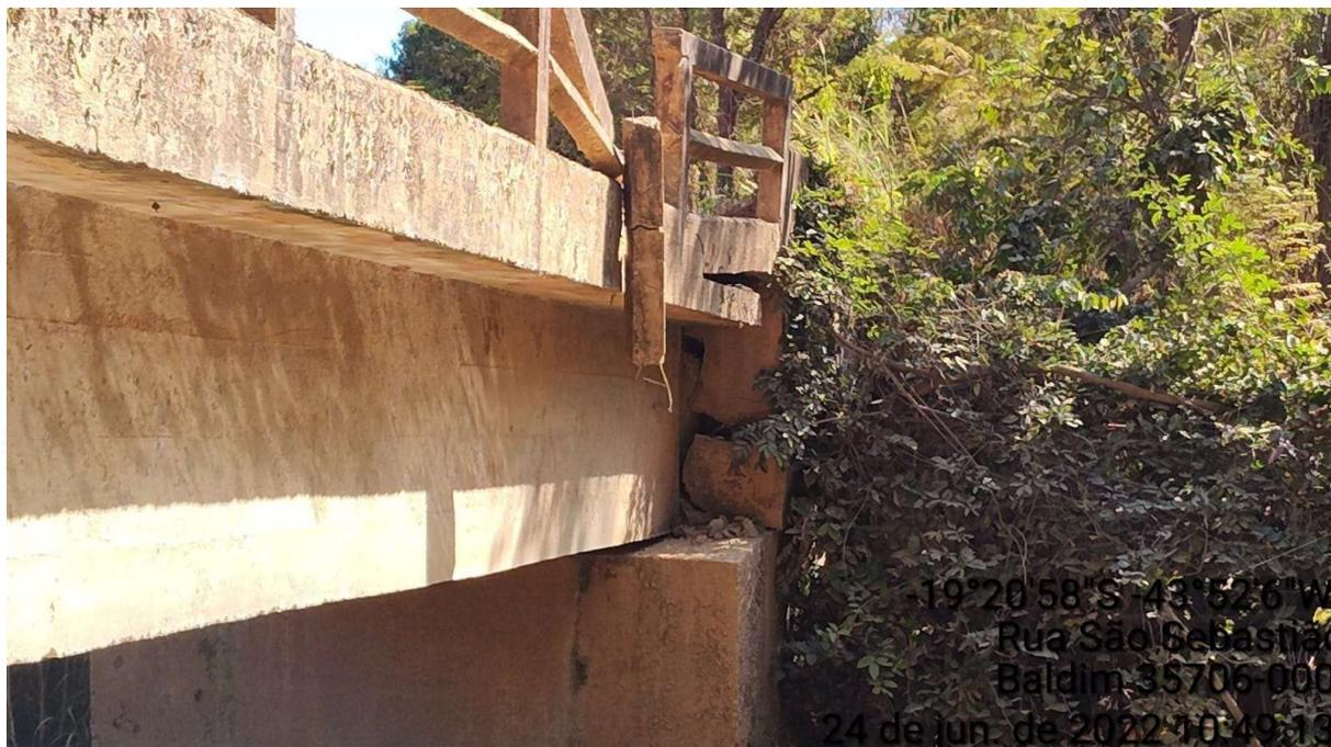
**Foto 8:** Na vista Lateral Direita Aproximada da Ponte em Concreto Armado (Lado do Povoado da Cuia) Bloco de Fundação Recalcado, Parte do Guarda-Corpos Desmoronada, Rachaduras no Guarda-Rodas e Guarda-Corpos. Fonte: Próprio Autor, 2022.
