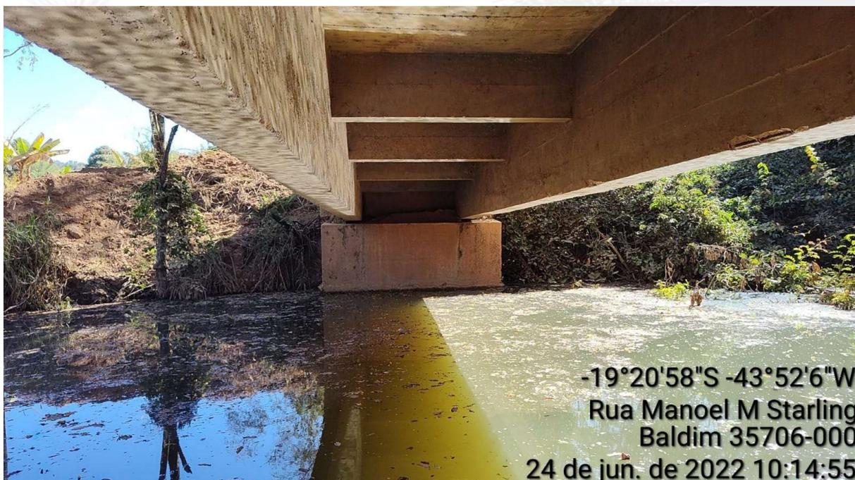
**Foto 9:** Na Vista sob a Ponte em Concreto Armado (Lado do Povoado da Cuia) Bloco de Fundação Recalcado. Fonte: Próprio Autor, 2022.
