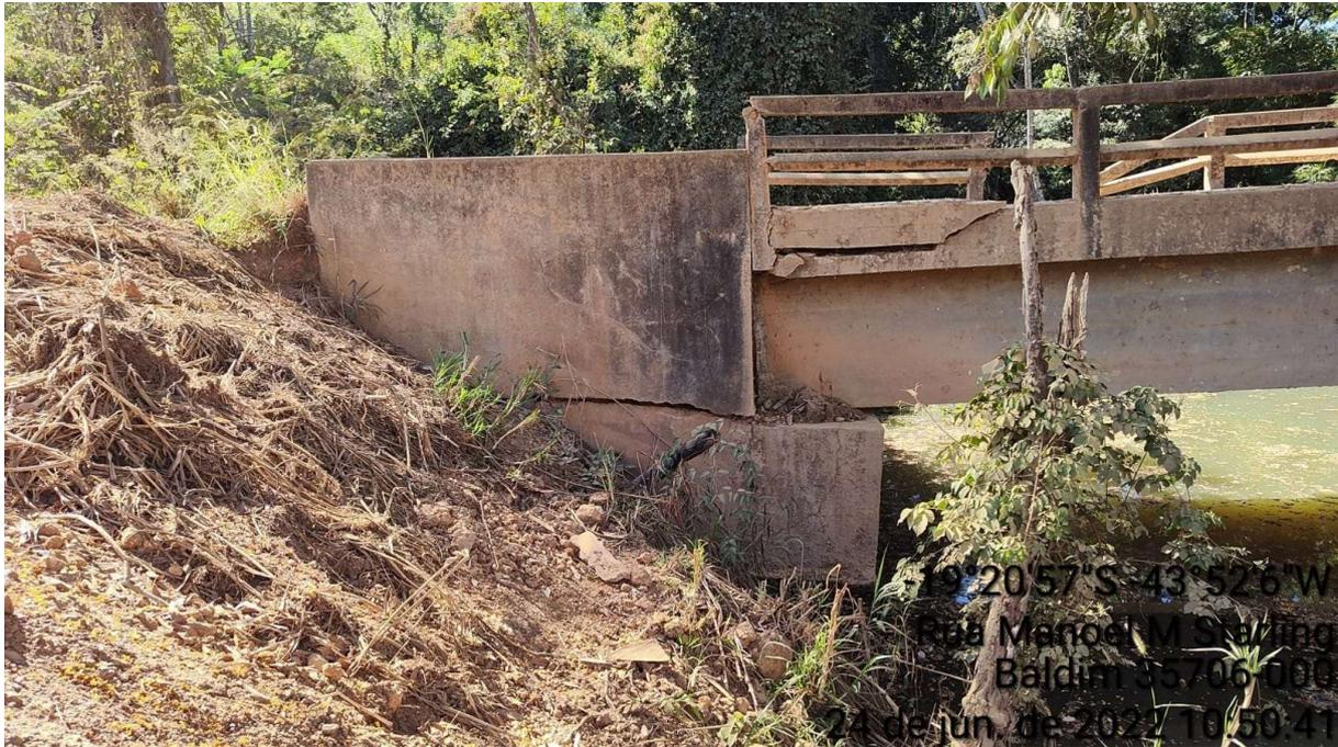
**Foto 6:** Na vista Lateral Esquerda Aproximada da Ponte em Concreto Armado (Lado do Povoado da Cuia) Bloco de Fundação Recalcado, Tabuleiro desnivelado e Rachaduras no Guarda-Rodas e Guarda-Corpos. Fonte: Próprio Autor, 2022.
