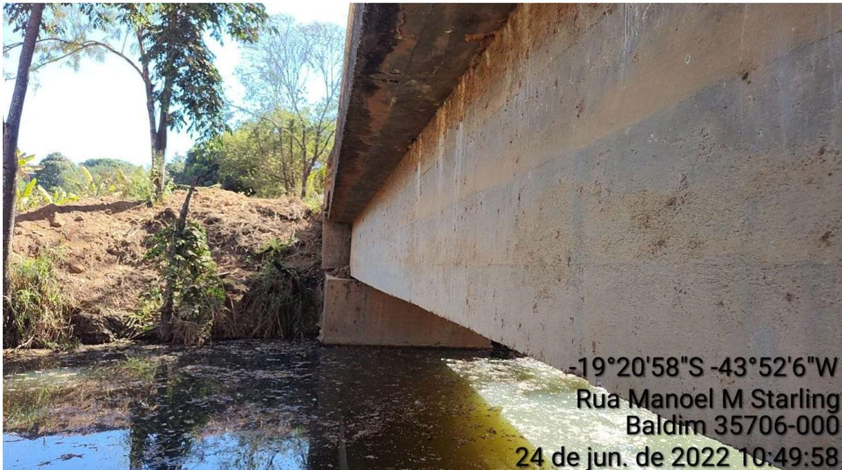
**Foto 4:** Na Vista Lateral Esquerda da Ponte em Concreto Armado (Lado do Povoado da Cuia) Bloco de Fundação Recalcado. Fonte: Próprio Autor, 2022.
