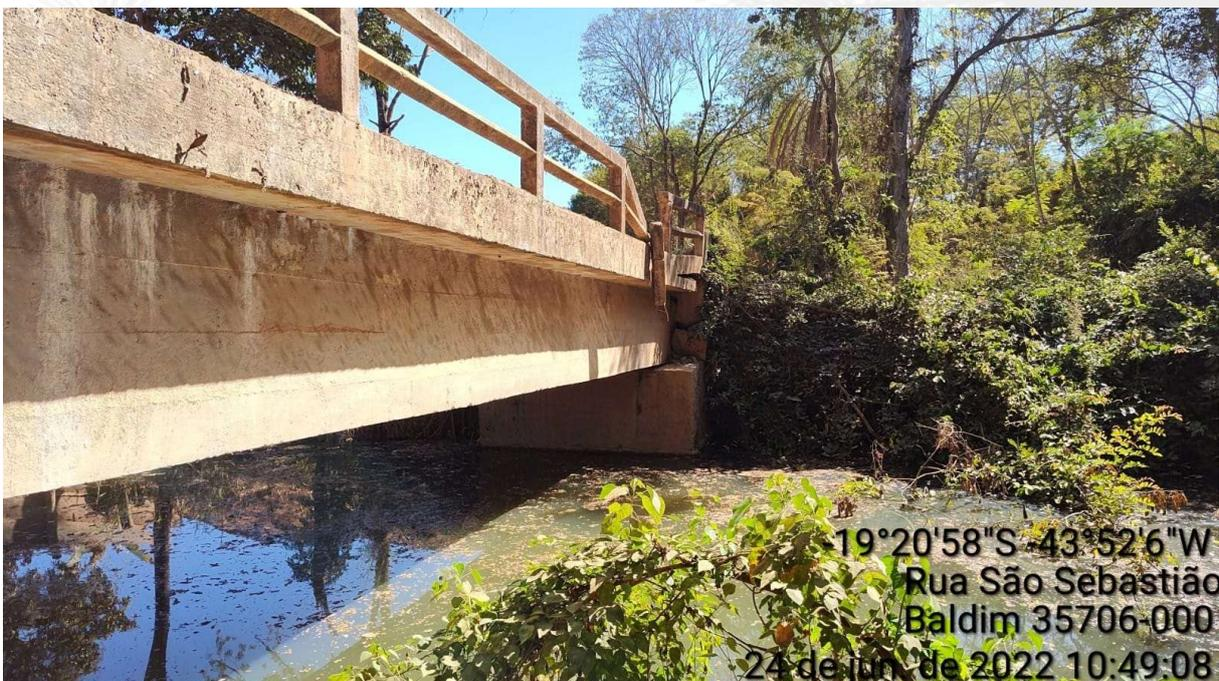
**Foto 7:** Na vista Lateral Direita da Ponte em Concreto Armado (Lado do Povoado da Cuia) Bloco de Fundação Recalcado, Parte do Guarda-Corpos Desmoronada, Rachaduras no Guarda-Rodas e Guarda-Corpos. Fonte: Próprio Autor, 2022.
