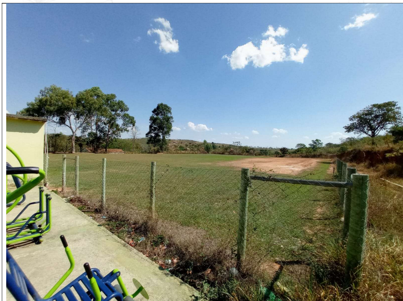
Foto 1: Vista da lateral direita do campo em relação ao vestiário. Fonte: Próprio autor.
